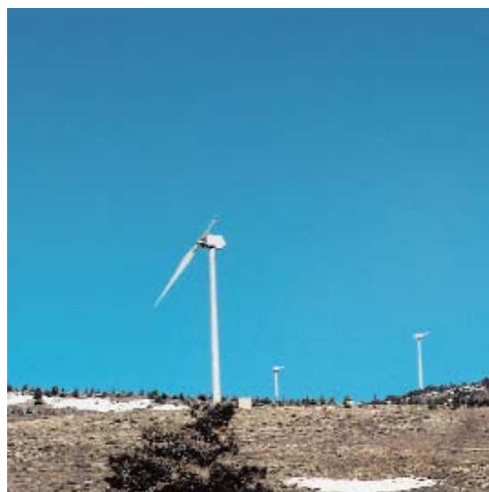
Parco eolico del Comune di Collarmele (AQ).
